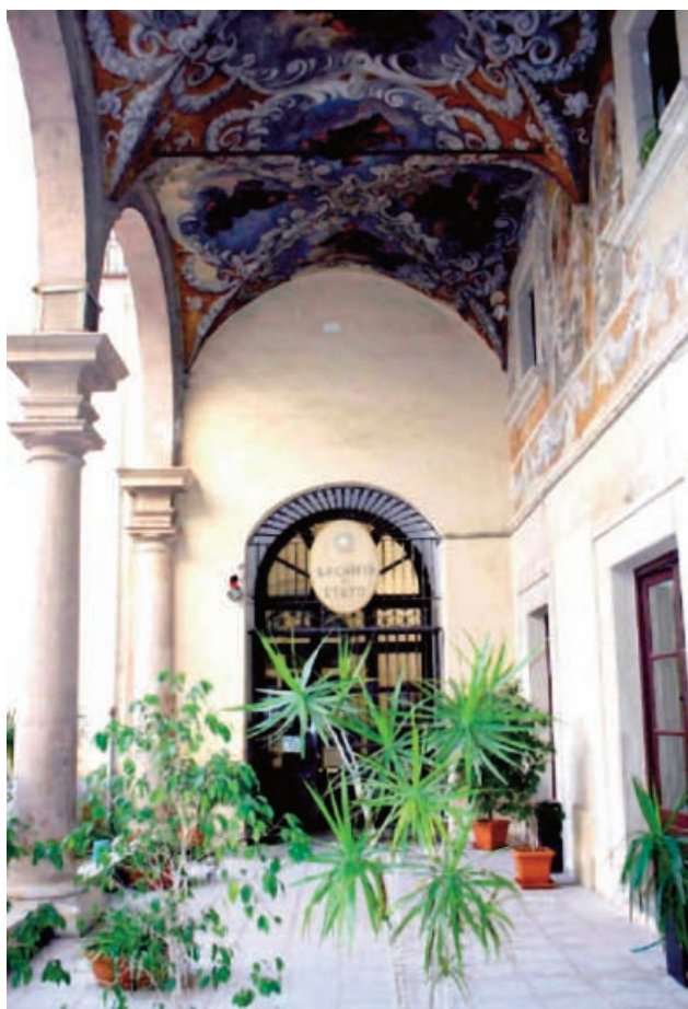
Particolare del porticato d'ingresso
