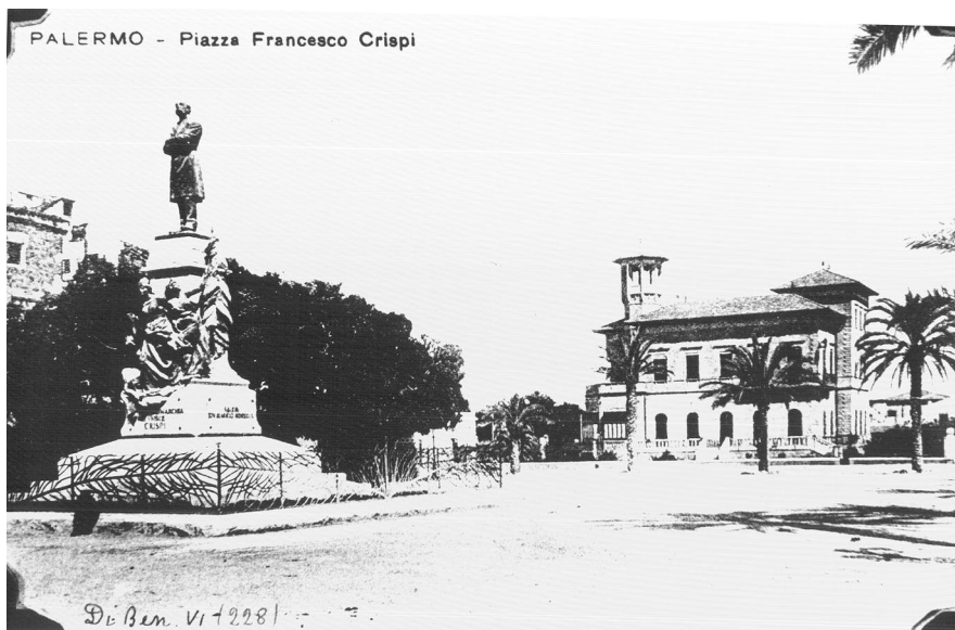
Villa Deliella progettata da Ernesto Basile, costruita nel lato est della Piazza Francesco Crispi tra il 1905 ed 1909 (Foto Archivio Di Benedetto)
